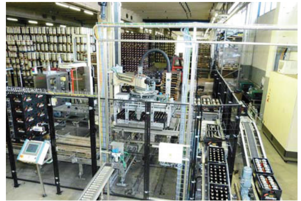
Arbeitsplatz des Säulenpalettierers „MultiPal“ (ganz links die Vollgutpaletten, im Hintergrund die Sixpack-Palette, rechts die beiden Bahnen mit den Einzelflaschen sowie den Sixpacks).
