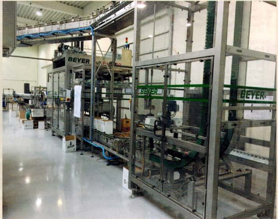
Abb. 2 Der komplette Trockenteil aus einer Hand: Einbringung von Neuglas, Flaschen- und Kisten-Transport sowie Aus- und Einpacker
