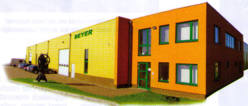
Firmenansicht der Beyer Maschinenbau GmbH, die 2002 ihren Sitz im Roßweiner Gewerbegebiet „Goldene Höhe“ bezog
